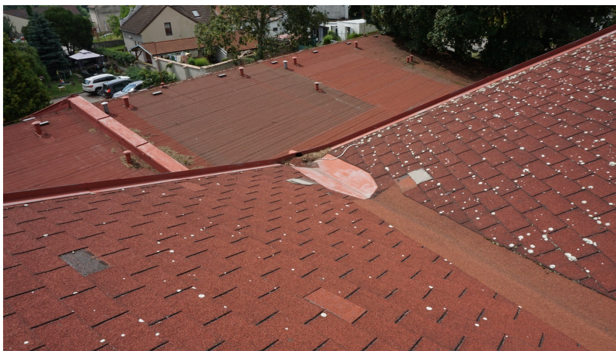
Foto č. 6 – objekt D – nevhodné odvodnění
