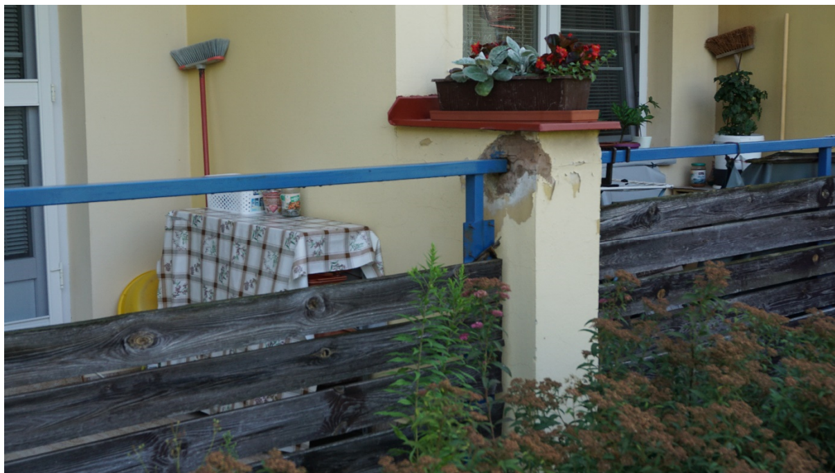
Foto č. 13 – objekt D, E – poškození zábradlí
