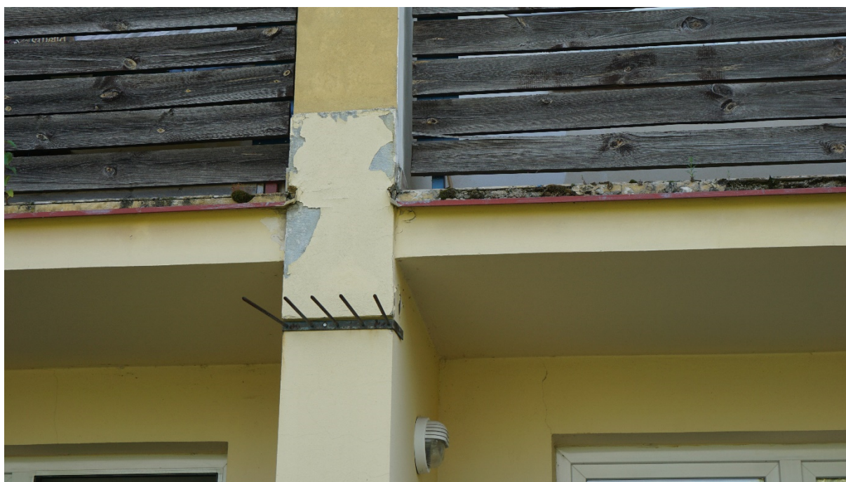
Foto č. 12 – objekt D – projevy zatékání do lodžii
