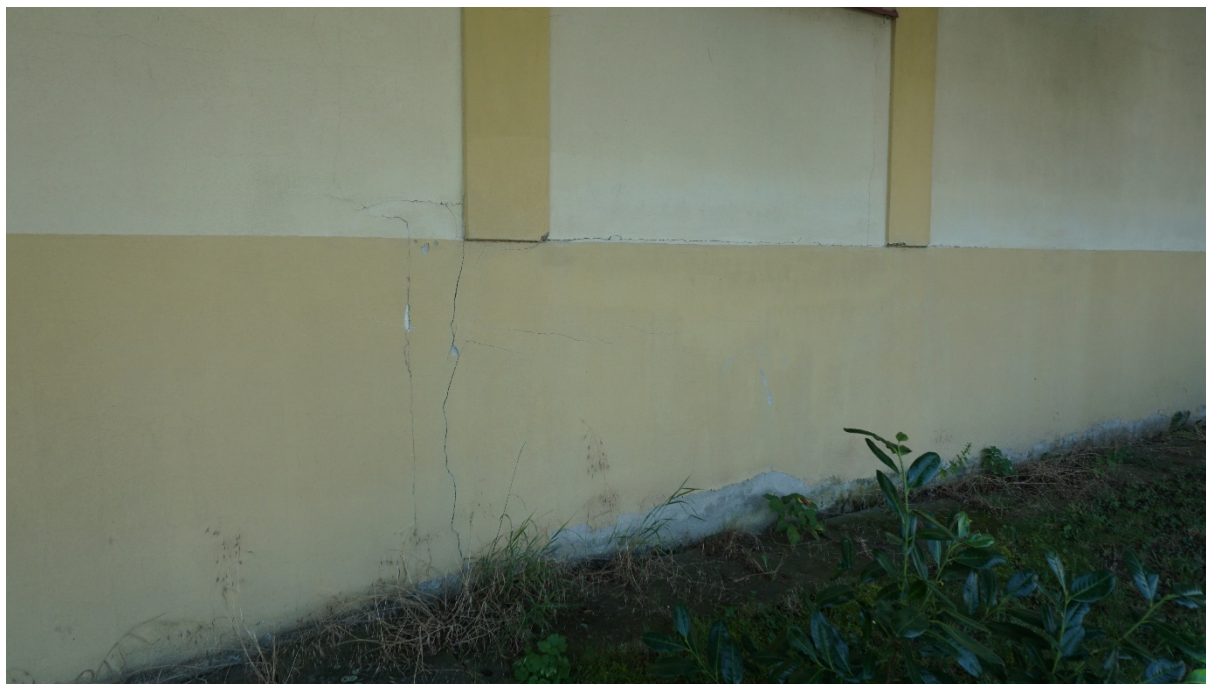
Foto č. 15 – Objekt D – poškození odstříkující vodou v místě soklu s vlasečnicové praskliny omítky
