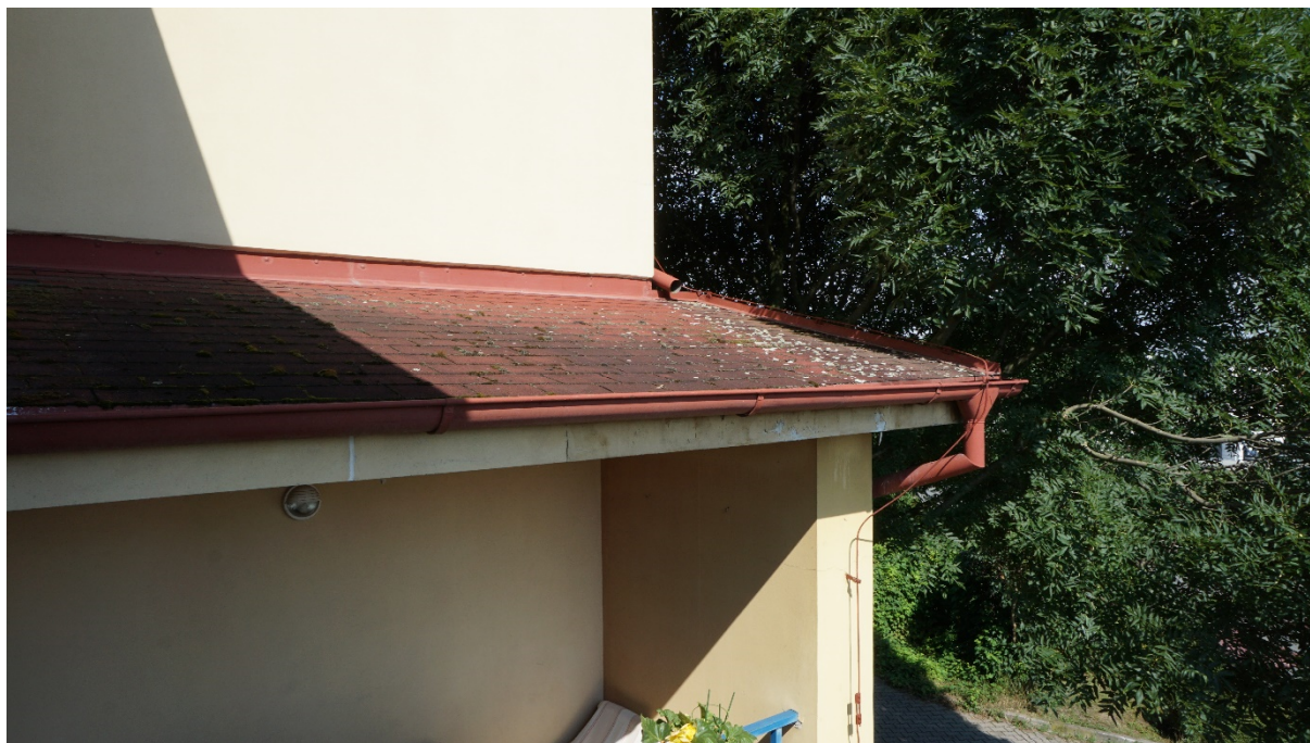
Foto č.7 – objekt D – svod ze střech na střechu s projevem zatékání
