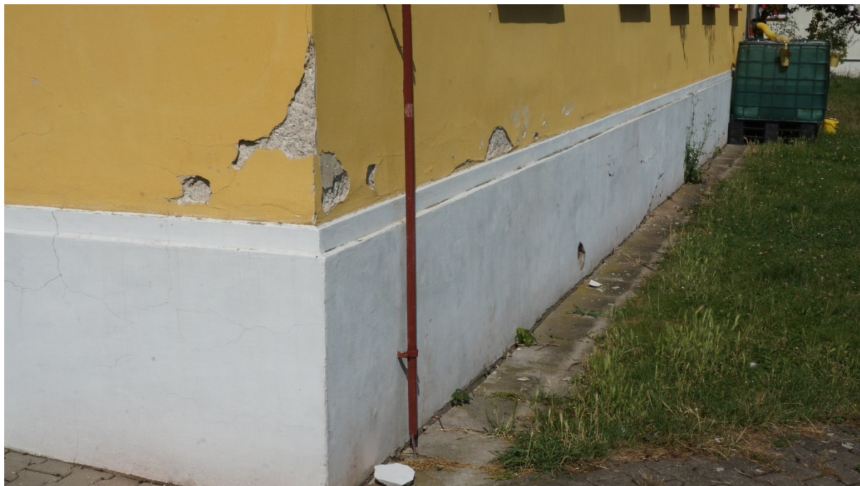
Foto č. 14 – Objekt A – vzlínající vlhkost
