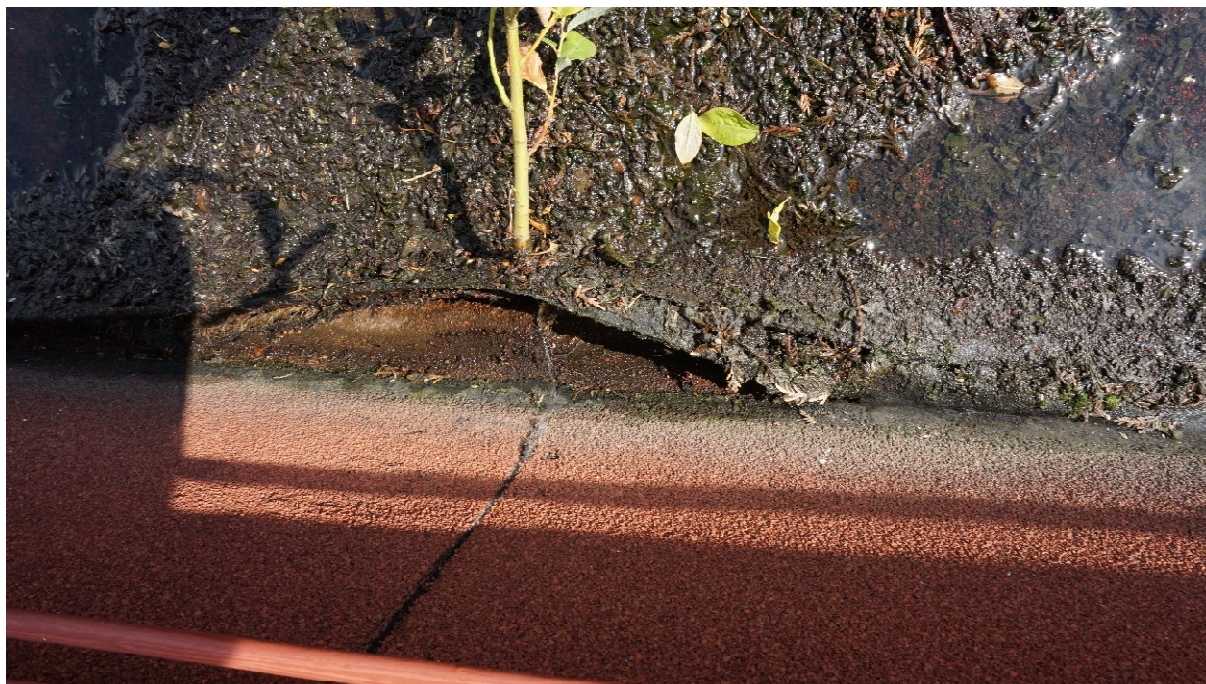
foto č.3 – objekt B – prorůstající vegetace do spáry střešního pláště
