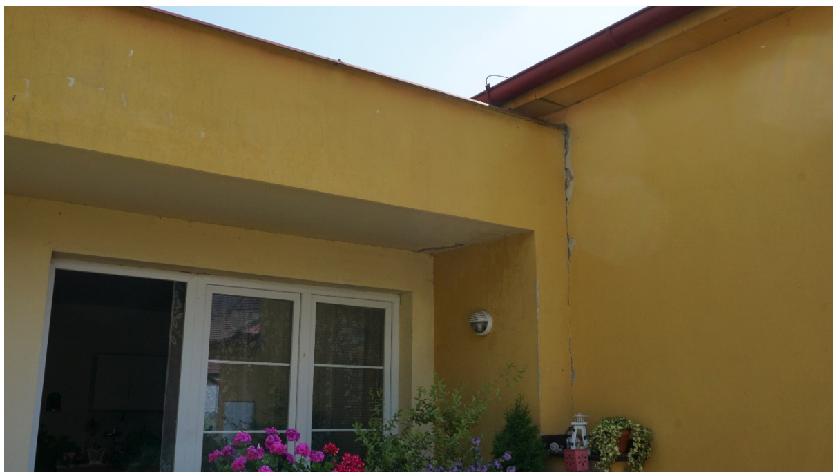
foto č.4 – objekt B – projev zatékání v místě vpusti
