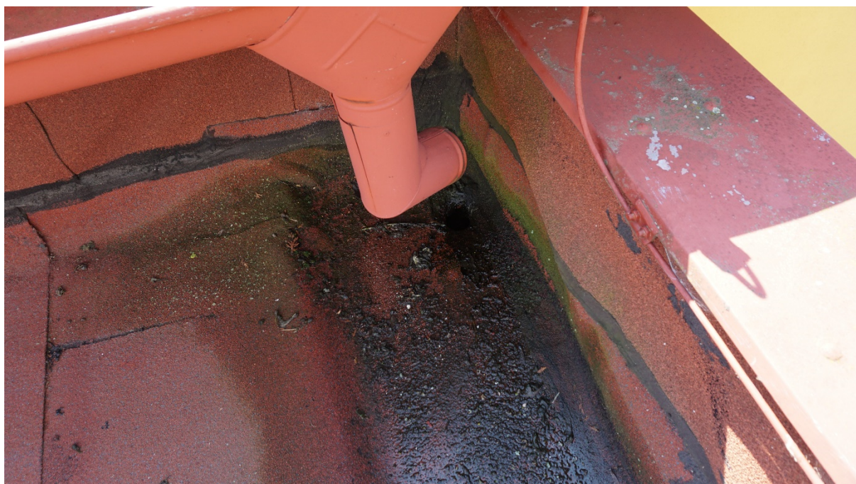
foto č.2 – objekt B – detail nevhodného řešení střeni vpusti, která je současně zatížena svodem ze sousední části
