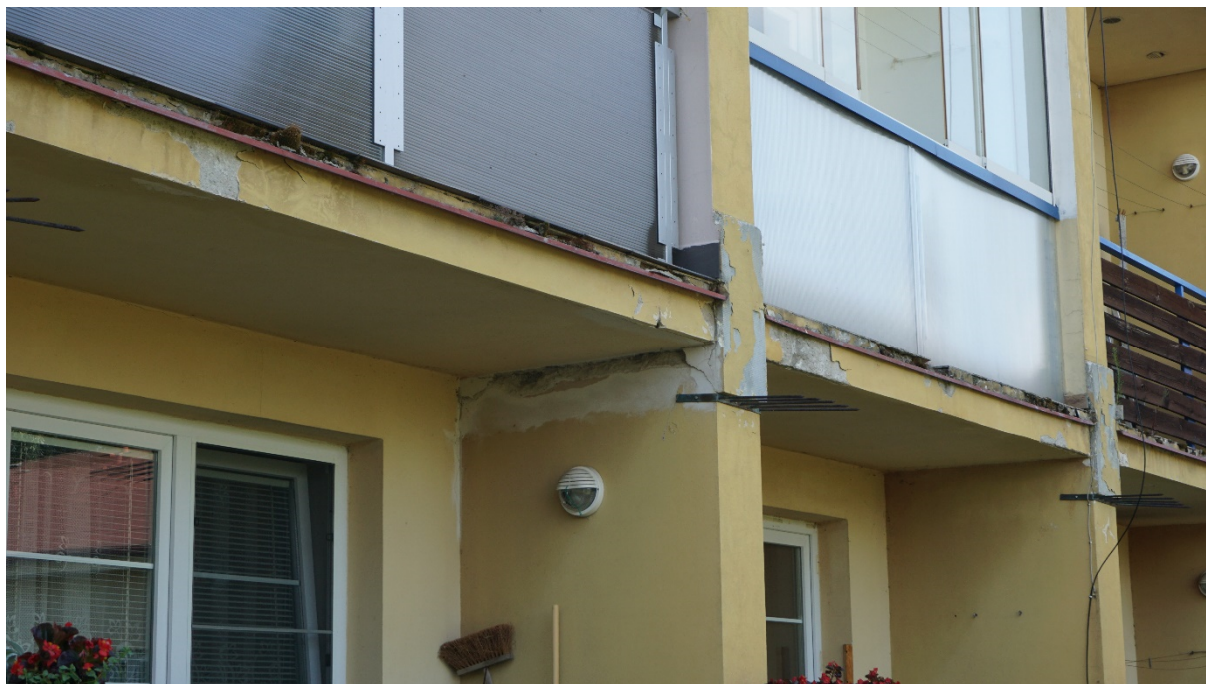
Foto č. 11 – objekt D – projevy zatékání do lodžii
