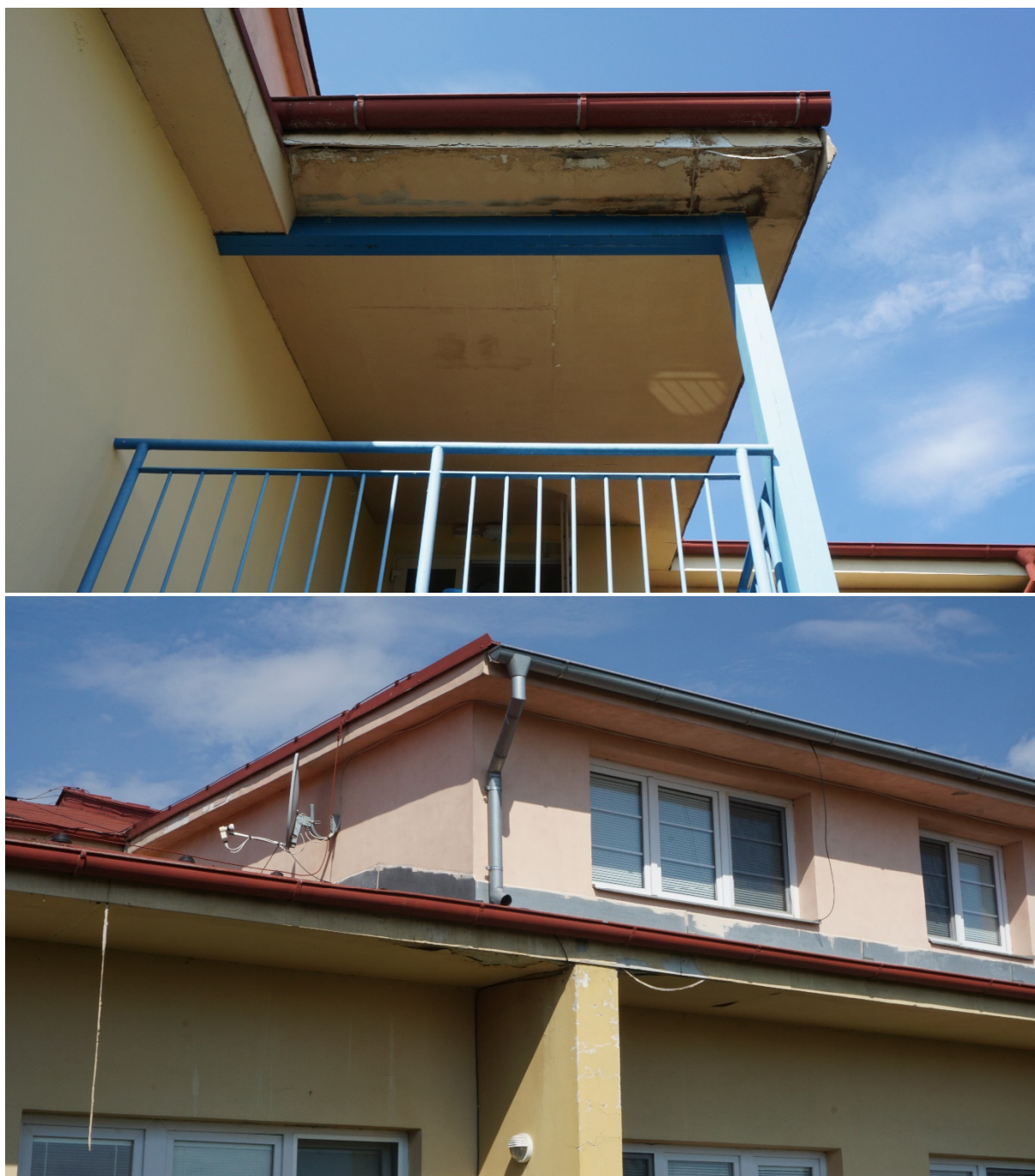
Foto č. 9, 10 – objekt D – projevy zatékání do střešní konstrukce
