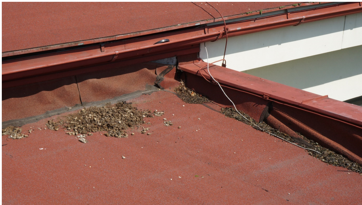
foto č.1 - objekt B – poškození střešního pláště
